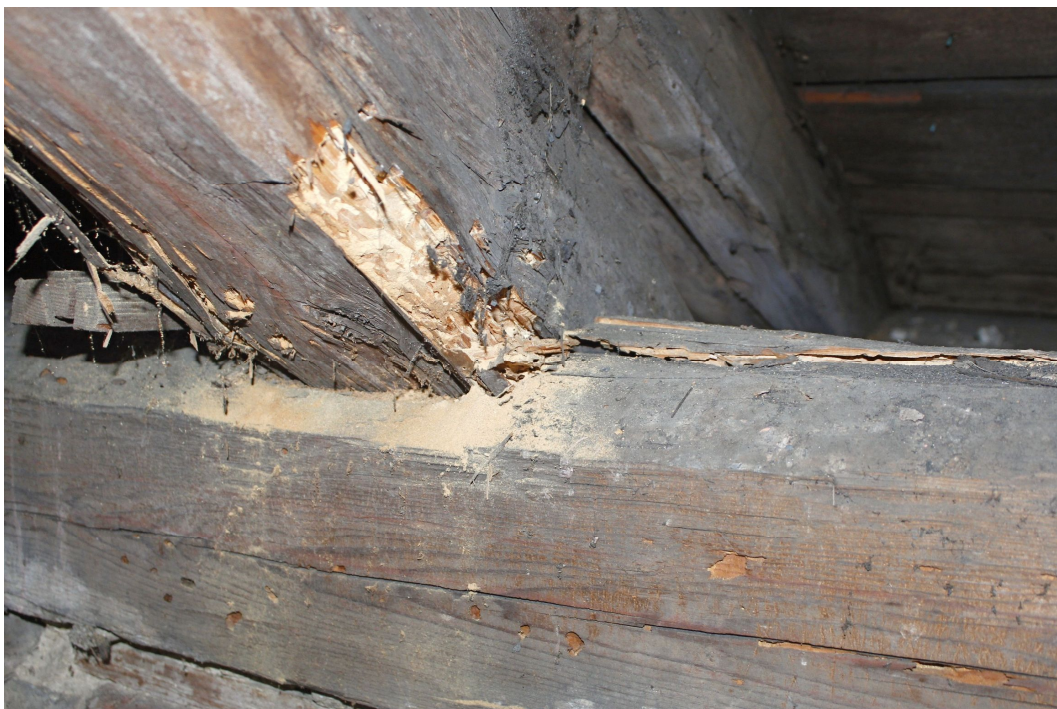
29. Detailní pohled na styk krokve s pozednicí a dřevo aktivně napadené tesaříkem (10/2015).
