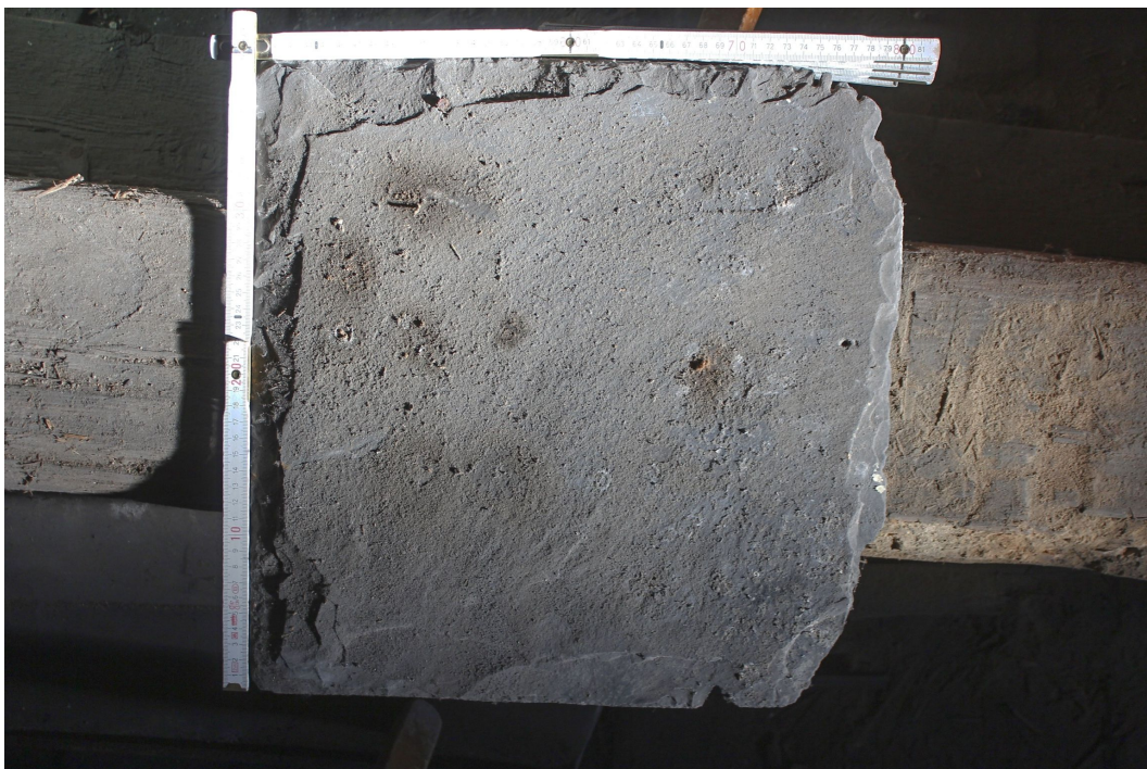
26. Detailní pohled na původní střešní krytinu nalezenou na půdě JV křídla – šablona ze štípané břidlice formátu 400x400 mm.
