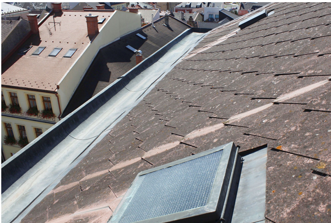
17. Detailní pohled na nástřešní žlab a střešní výlez na hlavním průčelí JV křídla.
