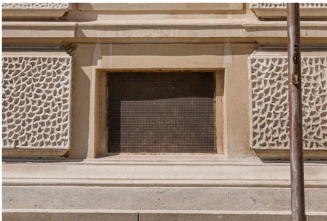
42. Detail větrací mřížky do sklepa v soklu v západní části JV průčelí JV křídla budovy.
