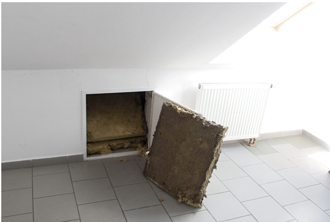
25. Pohled na vstupní otvor do trojúhelníkové části nad okapem u vestavěného podkroví středního křídla s výplní zateplenou minerální vatou.
