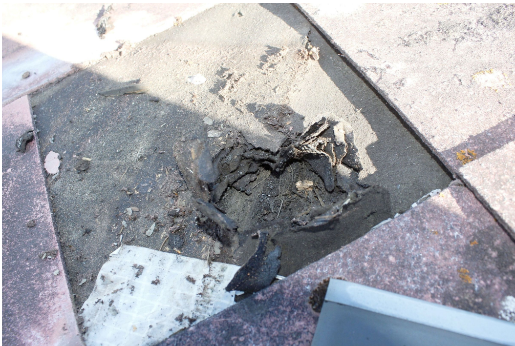
13. Detailní pohled do sondy ve střešní krytině – pod uvolněnou šablonou se nachází souvrství minimálně dvou podkladních asfaltových lepenek.
