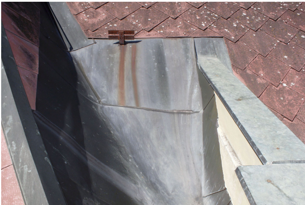
19. Pohled na ukončení zaatíkového žlabu za bokem balustrádového zábradlí na hlavním průčelí JV křídla.
