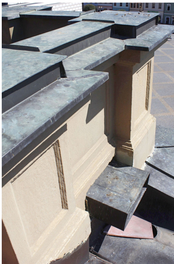
21. Detailní pohled na prostup zaatíkového žlabu bokem balustrádového zábradlí na hlavním průčelí JV křídla.
