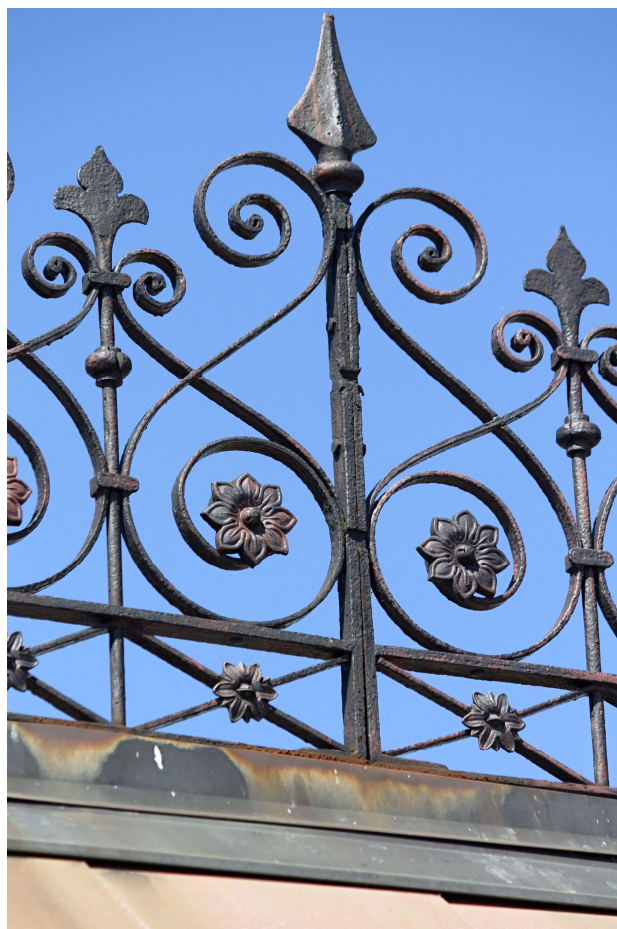
23. Detailní pohled na část kovaného ozdobného zábradlí na hřebeni JV křídla.
