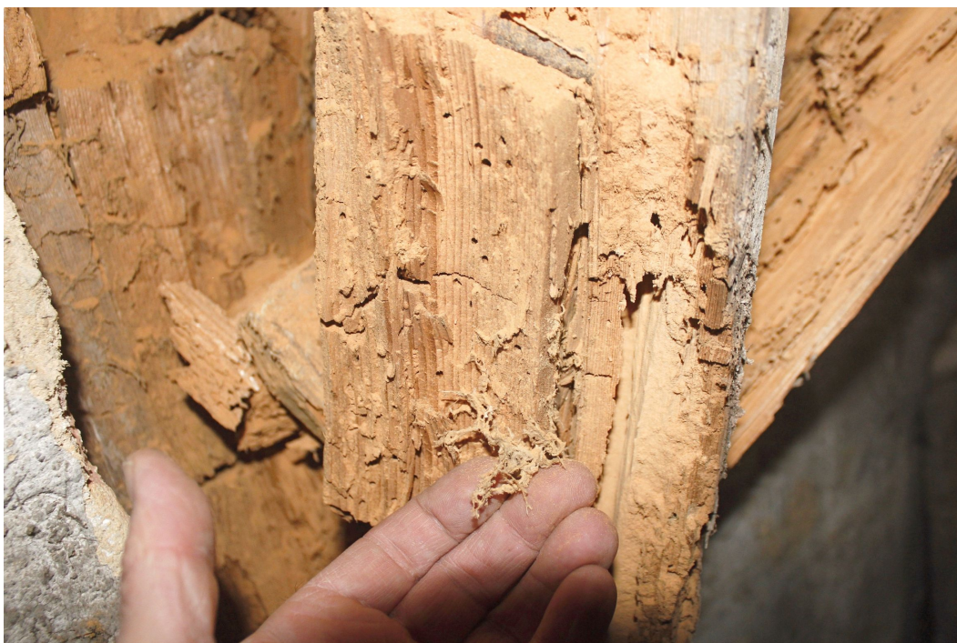
32. Detailní pohled na sloupek v nadezdívce krovu s částí mycelia dřevomorky.
