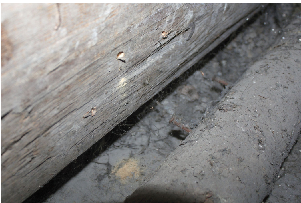
30. Detailní pohled na vazný trám s čerstvými výletovými otvory tesaříka (10/2015).
