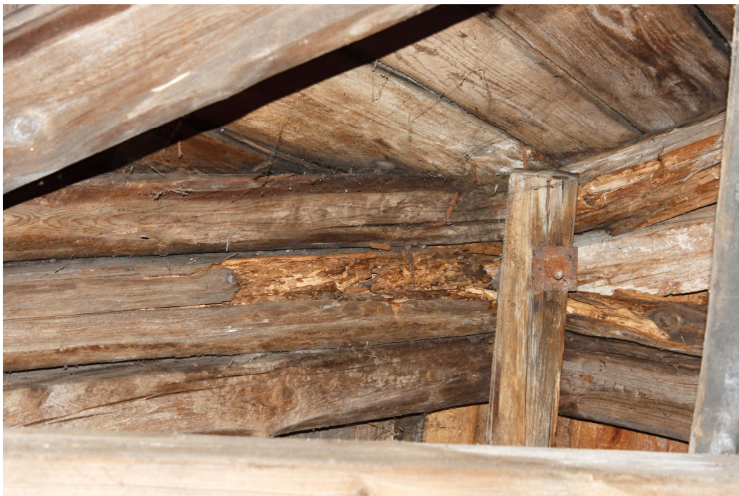
31. Vertikální pohled na půdě JV křídla na styk dřevěných prvků krovu silně napadených dřevokaznou houbou, vpravo ve vaznici je zřejmá matka a ocelová kotva ozdobného zábradlí na hřebeni střechy.
