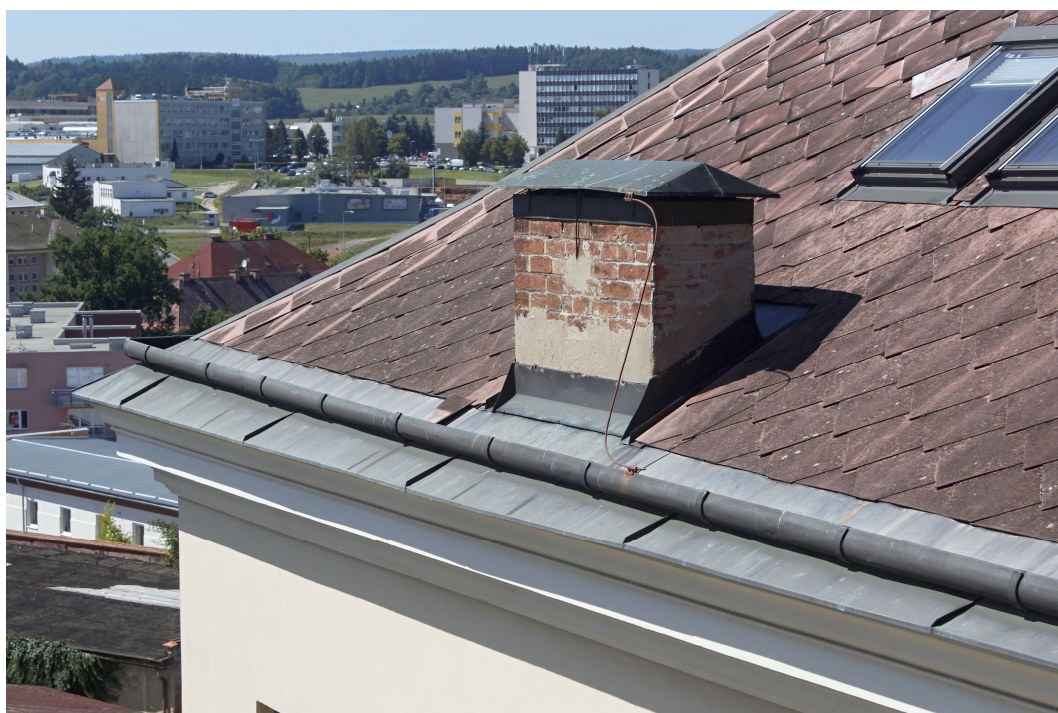
10. Detailní pohled na zaslepený komín a ukončení oplechování okapu s nástřešním žlabem u JV střechy SZ křídla budovy.
