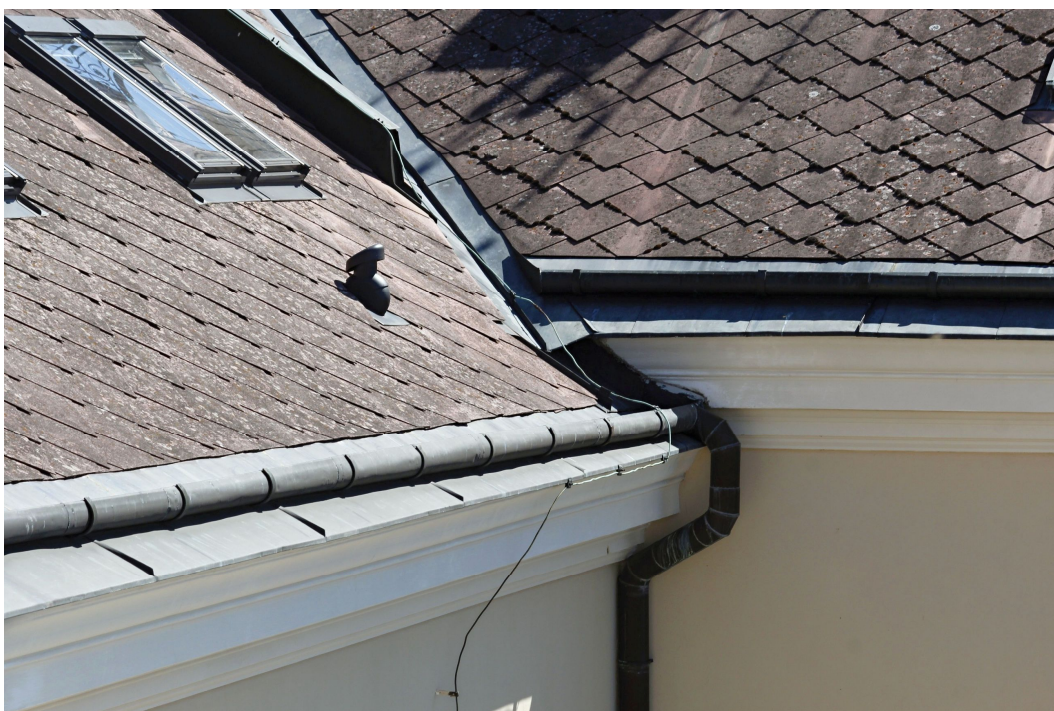
8. Detailní pohled na průnik střešních rovin středního a hlavního JV křídla budovy.
