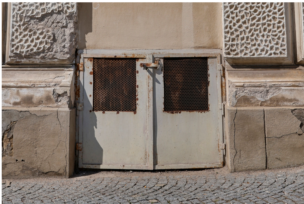
41. Detail dvířek s větrací mřížkou do sklepa v soklu v západní části JV průčelí JV křídla budovy.
