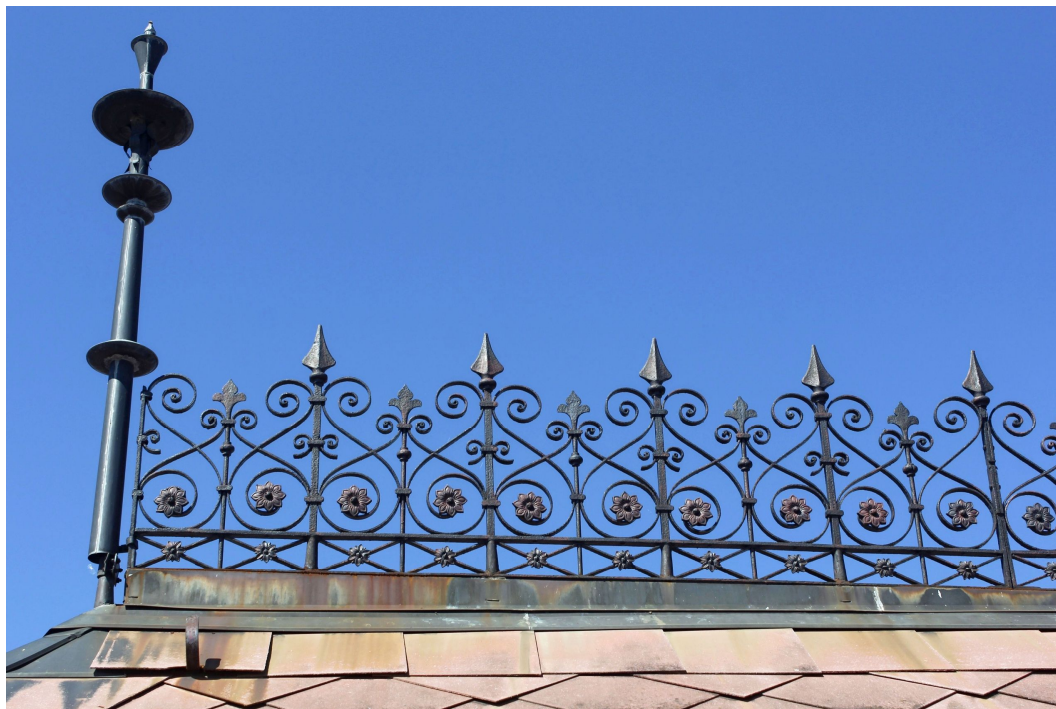
23. Detailní pohled na část kovaného ozdobného zábradlí na hřebeni JV křídla.
