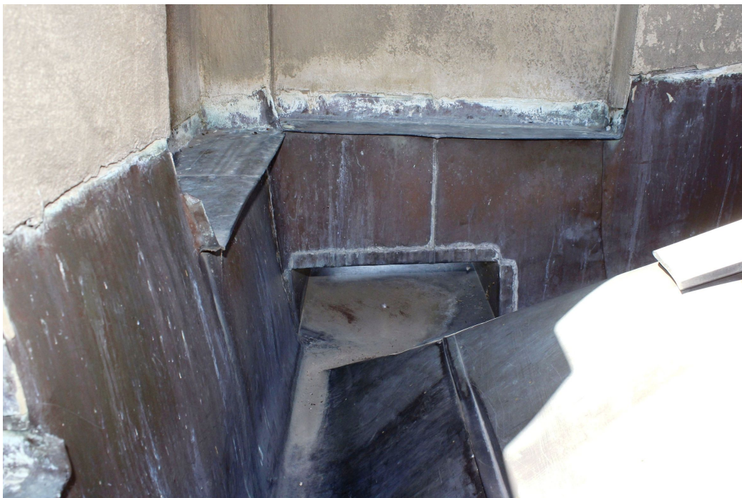
21. Detailní pohled na prostup zaatíkového žlabu bokem balustrádového zábradlí na hlavním průčelí JV křídla.
