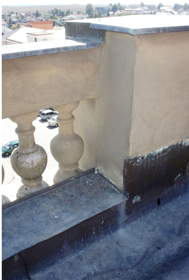
19. Pohled na ukončení zaatíkového žlabu za bokem balustrádového zábradlí na hlavním průčelí JV křídla.
