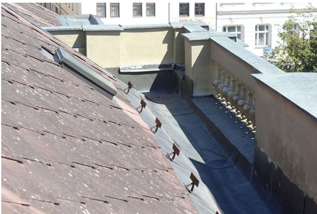
18. Detailní pohled na zaatikový žlab a vnitřní oplechování balustrádového zábradlí na hlavním průčelí JV křídla.
